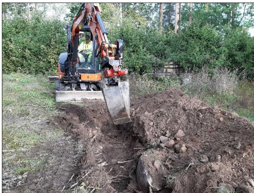
Kallio ja kivet vaikeuttivat kaapeliojan kaivuuta.
