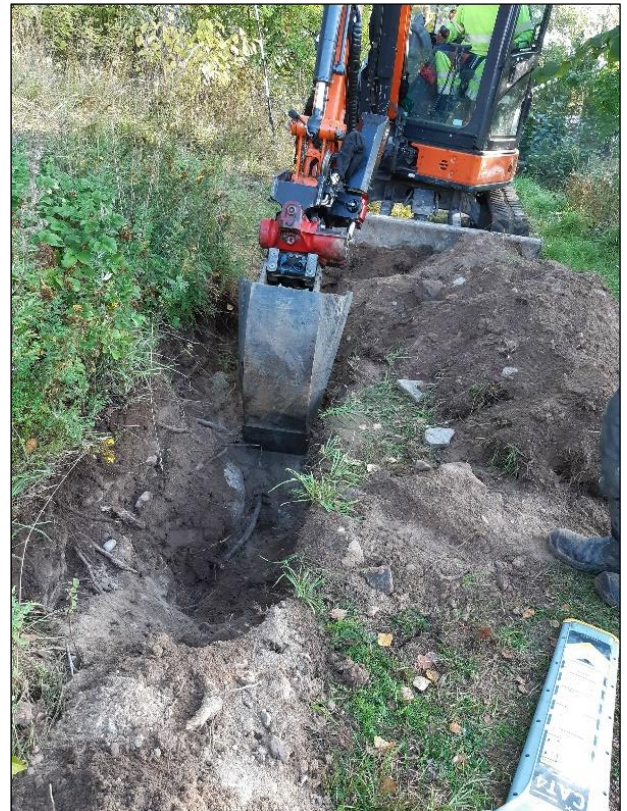
Vasen: kaivuu aloitettiin pihatien pohjoispenkasta läheltä valaisinylvästä. Oikea: aikaisemmin maahan kaivetut sähkökaapelit esiin kaivettuna.
