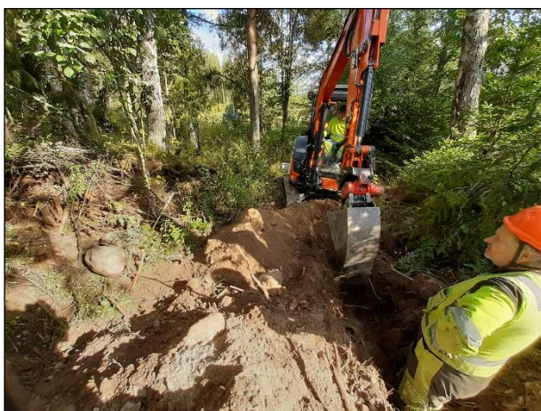
Vasen: kaapelioja kaivettiin hiekanottokuopan poikki muinaisjäännösalueen itäreunalla. Oikea: kaivannon leveys oli n. 30 – 40 cm.
