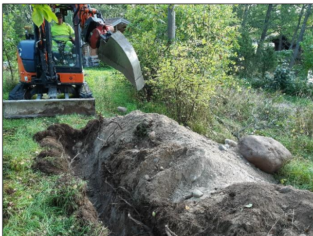
Vasen: maaperä pihan alueella oli hiekkaa, seassa oli joitakin suuria kiviä. Oikea: kaapelioja kaivettiin kahden piharakennuksen välistä, alueella oli aikaisempi kaapelikaivanto rakennusten välillä.
