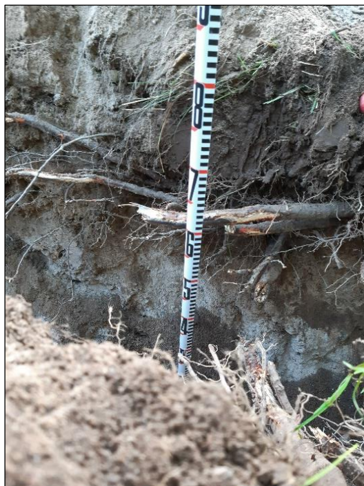
Vasen: kaivannon syvyys oli noin 80 cm. Oikea: kaivanto kulki omakotitalon pihapiirissä ja puutarhan alueella.
