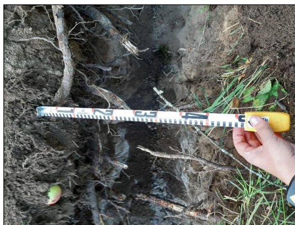
Vasen: kaapelioja kaivettiin hiekanottokuopan poikki muinaisjäännösalueen itäreunalla. Oikea: kaivannon leveys oli n. 30 – 40 cm.
